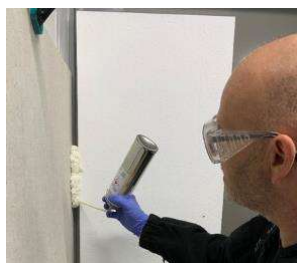
Mănuși de protecție
